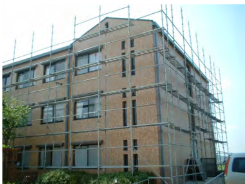
足場が組まれている建物の一部
